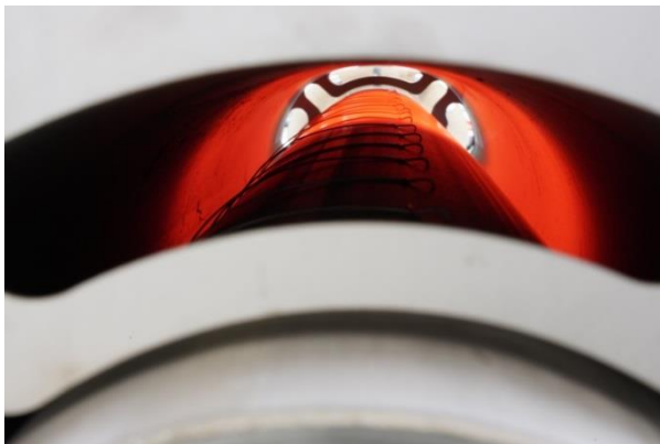
Temperaturmessungen an einer Strahlrohrbeheizung
